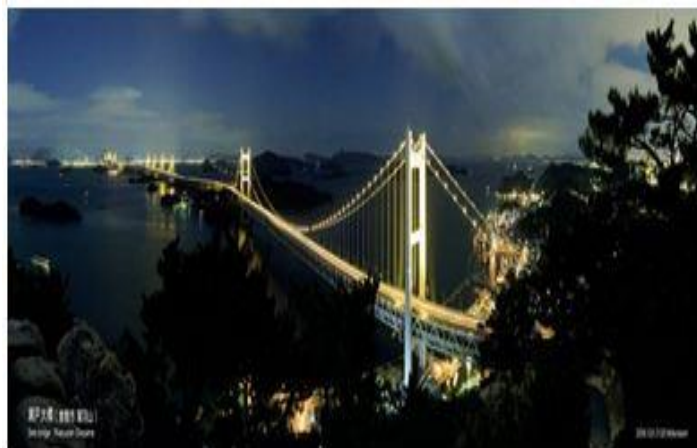
Hình 1: Cầu Seto Ohashi nối hai đảo Hôn-xiu và Xi-cô-cư.
